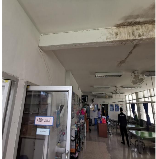
รอยแตกร้าวขยายเพิ่มอีกเล็กน้อยที่ผนังและฝ้าเพดานส่วนต่อเติมกับอาคารเดิม
