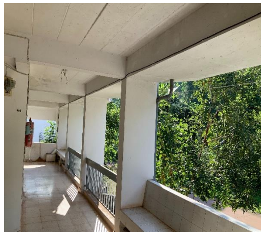
ไม่พบรอยแตกร้าวในส่วนของโครงสร้างหลักหรือจุดต่อของโครงสร้างหลัก
