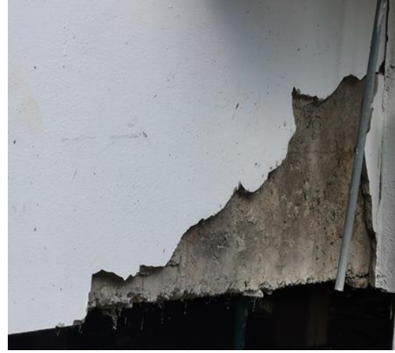
รอยแตกร้าวหลุดร่อนที่ผิวปูนฉาบข้างคาน ตรงจุดเชื่อมระหว่างอาคารหลักกับส่วนต่อเติม
