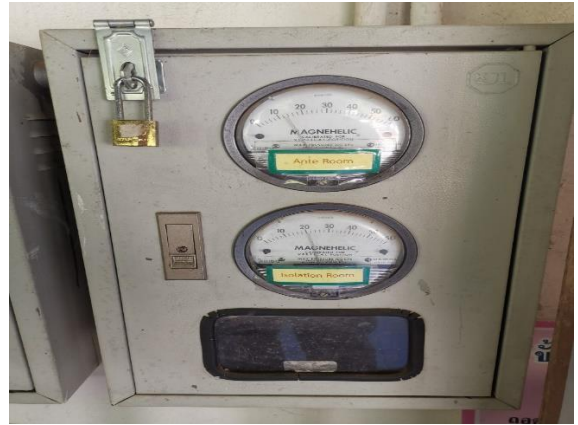
ตรวจสอบระบบระบายอากาศห้องแยกโรค
