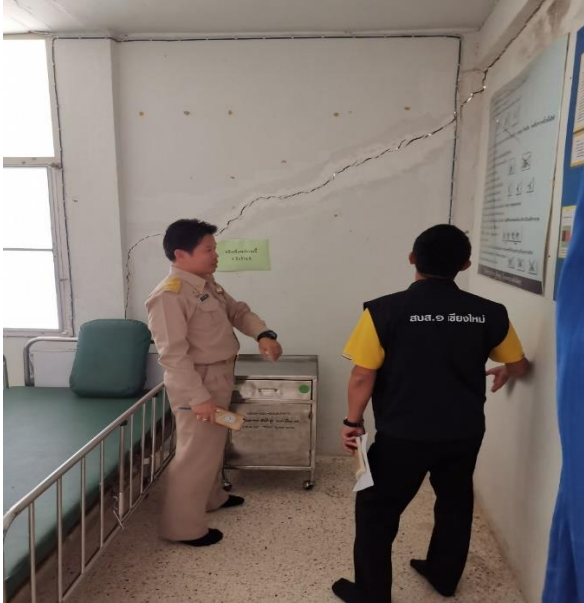
รอยแตกร้าวขยายเพิ่มอีกเล็กน้อยที่ผนังและฝ้าเพดานส่วนต่อเติมกับอาคารเดิม
