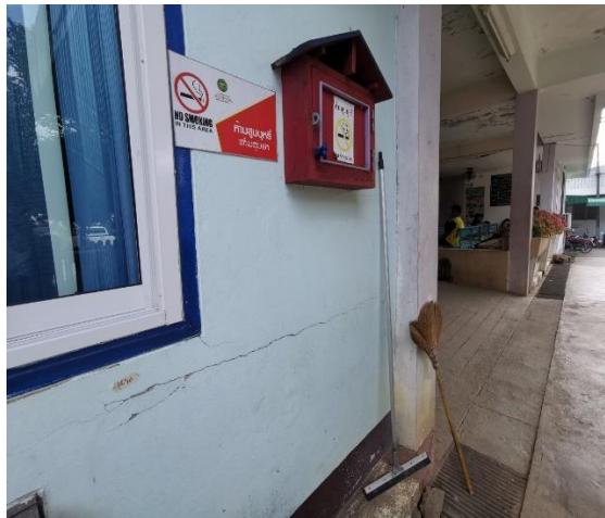
รอยแตกร้าวขนาดเล็กที่ผนังช่วงใต้เอ็นทับหลัง
