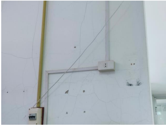
รอยแตกร้าวขนาดเล็กที่ผิวผนังเป็นบางจุด
