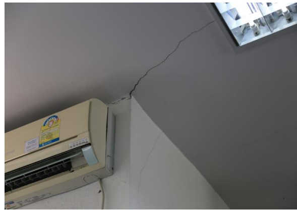
รอยแตกร้าวขนาดเล็กที่แผ่นฝ้าเป็นบางจุด
