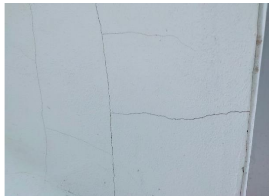
รอยแตกร้าวขนาดเล็กที่ฉีฉาบปูนผนังเป็นบางจุด
