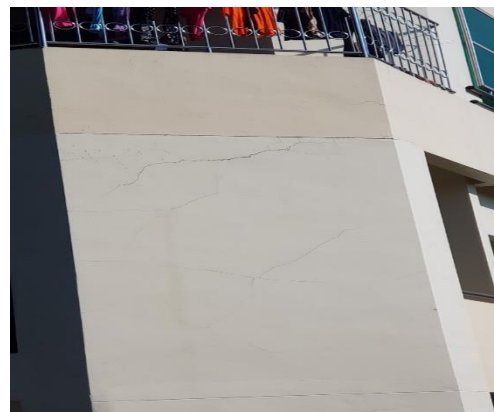
รอยแตกร้าวขนาดเล็กที่ผิวผนังเป็นบางจุด
