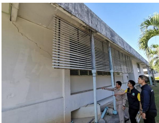
รอยแตกร้าวเฉียงขยายเพิ่มอีกเล็กน้อยที่ผนังส่วนต่อเติมกับอาคารเดิม
