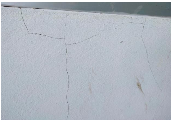
รอยแตกร้าวขนาดเล็กที่ฉีฉาบปูนผนังเป็นบางจุด
