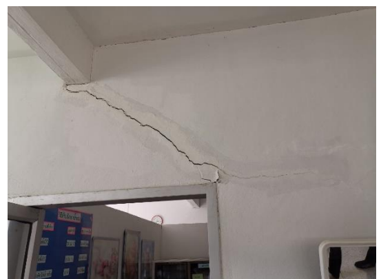
รอยแตกร้าวเฉียงขยายเพิ่มอีกเล็กน้อยที่ผนังส่วนต่อเติมกับอาคารเดิม
