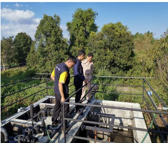
ตรวจสอบระบบบำบัดน้ำเสีย
