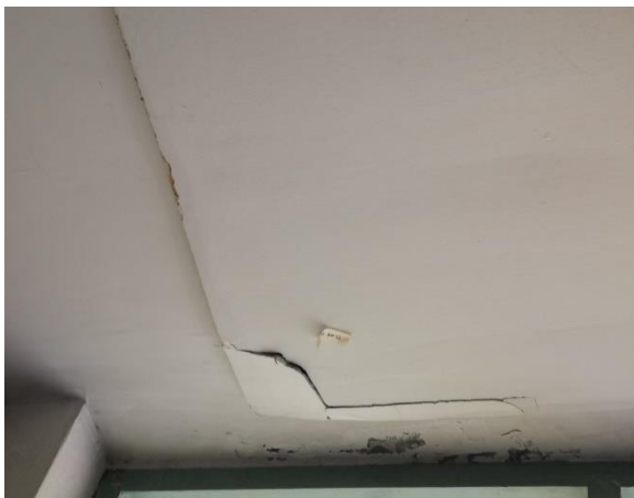
แผ่นฝ้าเพดานหลุดจากโครงคร่าว
