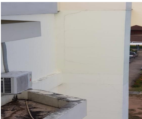
รอยแตกร้าวขนาดเล็กที่ผิวผนังเป็นบางจุด
