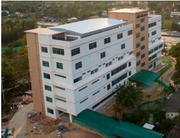
อาคารผู้ป่วยใน และอุบัติเหตุ 8 ชั้น รพ.เถิน
