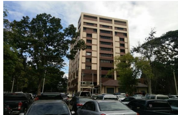
อาคารศูนย์แพทย์ฯ คสล.9 ชั้น รพ.นครพิงค์
