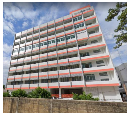
อาคารผู้ป่วยใน 144 เตียง คสล.7 ชั้น รพ.ฝาง
