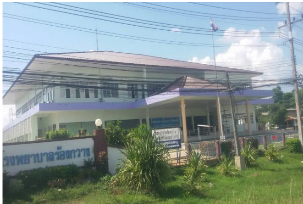
อาคารผู้ป่วยนอก คสล.2 ชั้น รพ.ร้อยกวาง
