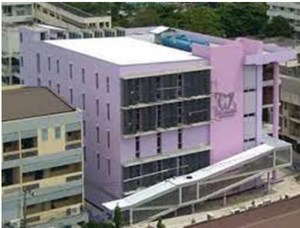
อาคารทันตกรรม คสล. 5 ชั้น รพ.ลำปาง
