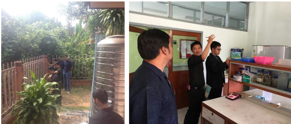
ตรวจสอบความเสียหายอาคารจาก เหตุการณ์แผ่นดินไหว
