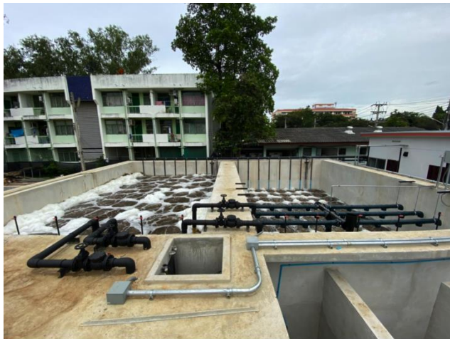
ระบบบำบัดน้ำเสีย 600 ลบ.ม. รพ.เกาะคา ลำปาง
