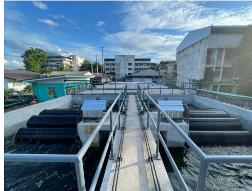
ระบบบำบัดน้ำเสีย ขนาด 1,000 ลบ.ม. รพ.น่าน
