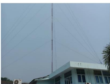
ตรวจสอบเสาส่งสัญญาณ/ สายอากาศ/ อุปกรณ์
